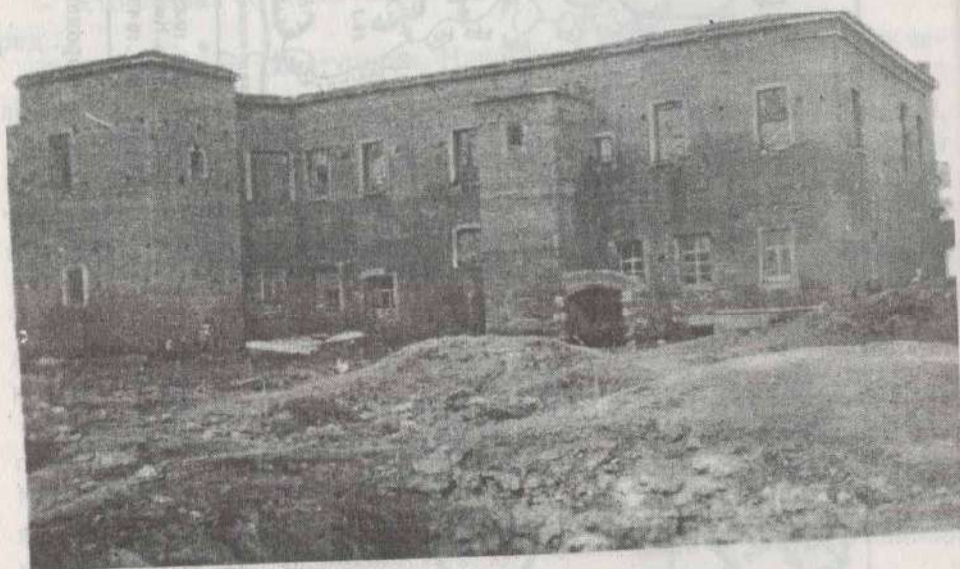
Дом связи на ул.Ленина, вид со двора
