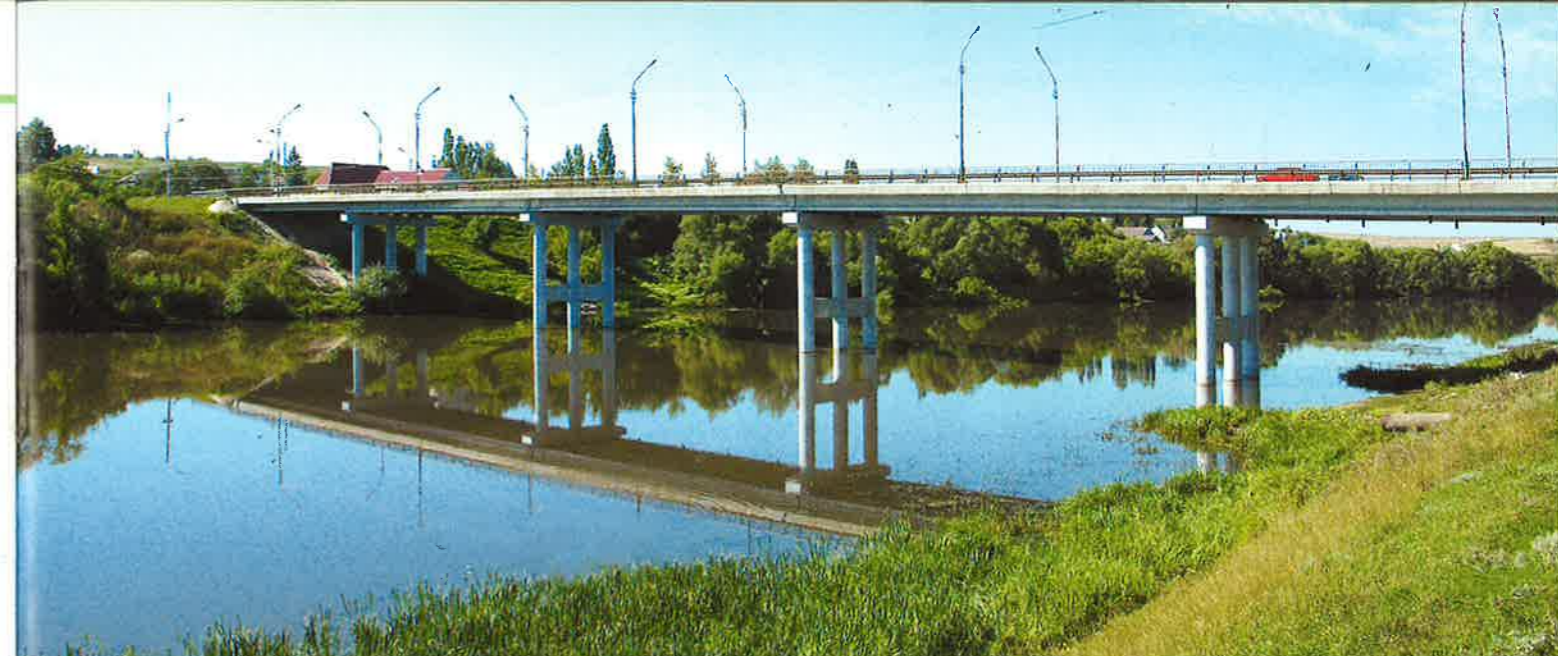
Мост через реку Сосну.
