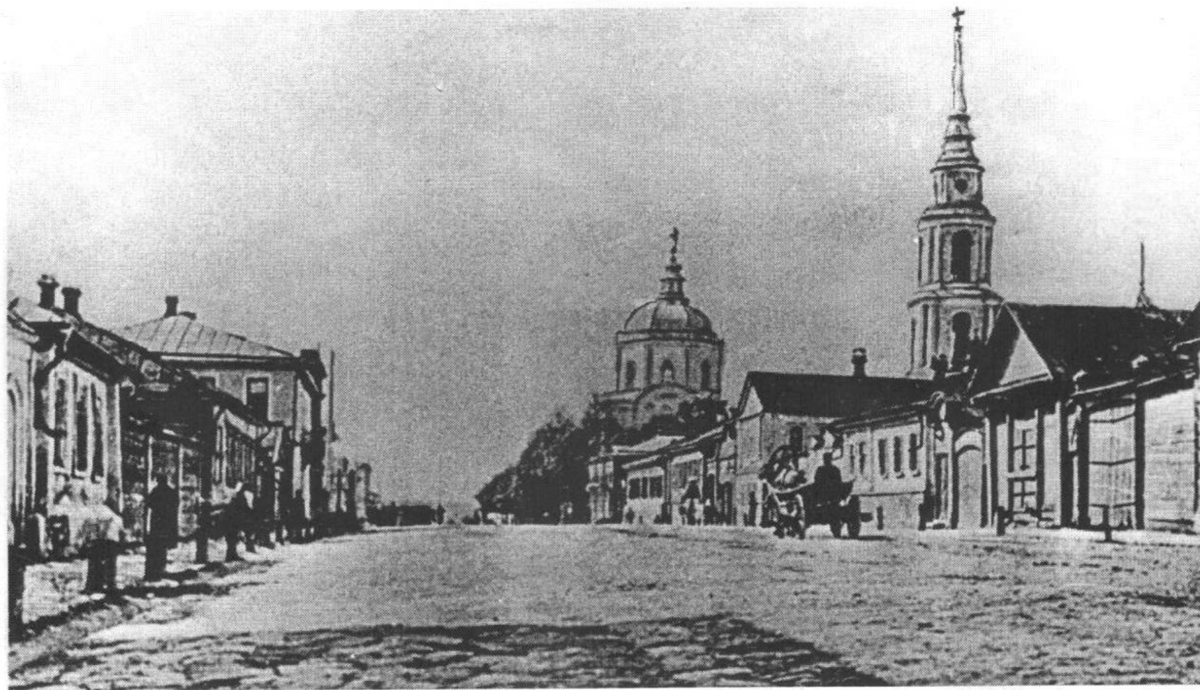
Вид улицы с перекрестка с улицей Новоникольской. Справа трапезная и колокольня Казанской церкви.
