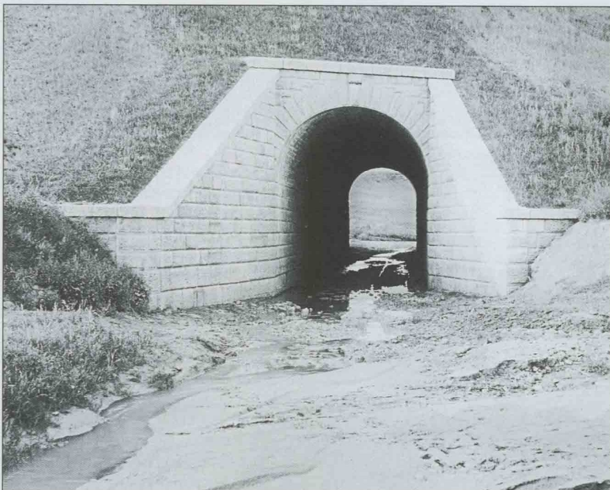
Косая труба отверстием 2 сажени на 90-й версте. Фото из фондов ЦНТБ.
