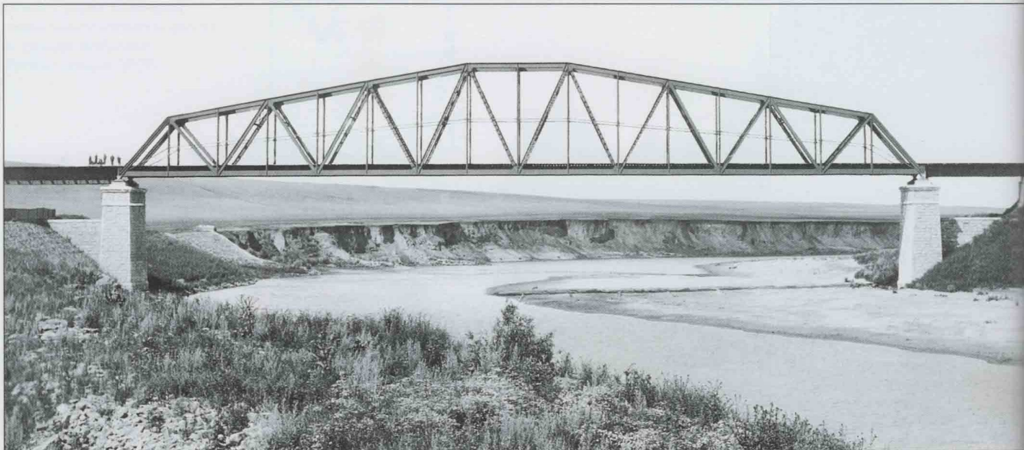
Мост через реку Сосну отверстием 50 сажен на 60-й версте участка Ливны-Мармыжи, построенного после перешивки дороги на широкую колею. Фото из фондов ЦНТБ.
