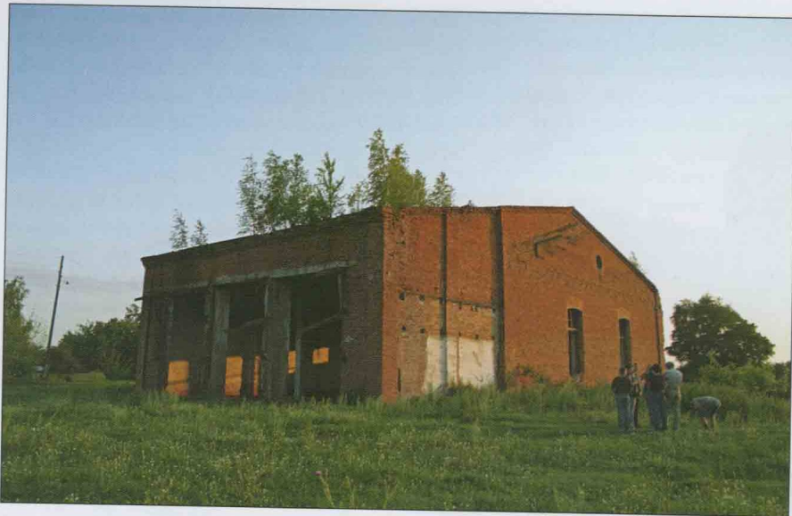
Бывшее веерное паровозное депо на станции Мармыжи. Видны следы поздней конструктивной переделки здания. Июль 2003 года. Фото Л. Сватикова.
