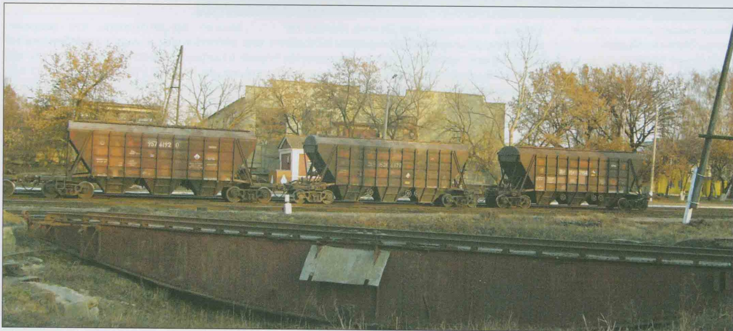
Старый уравновешенный ручной поворотный круг типа Селлера на станции Ливны. Планируется к разборке за отсутствием надобности. Вид сбоку. Фото М. Шаненкова.
