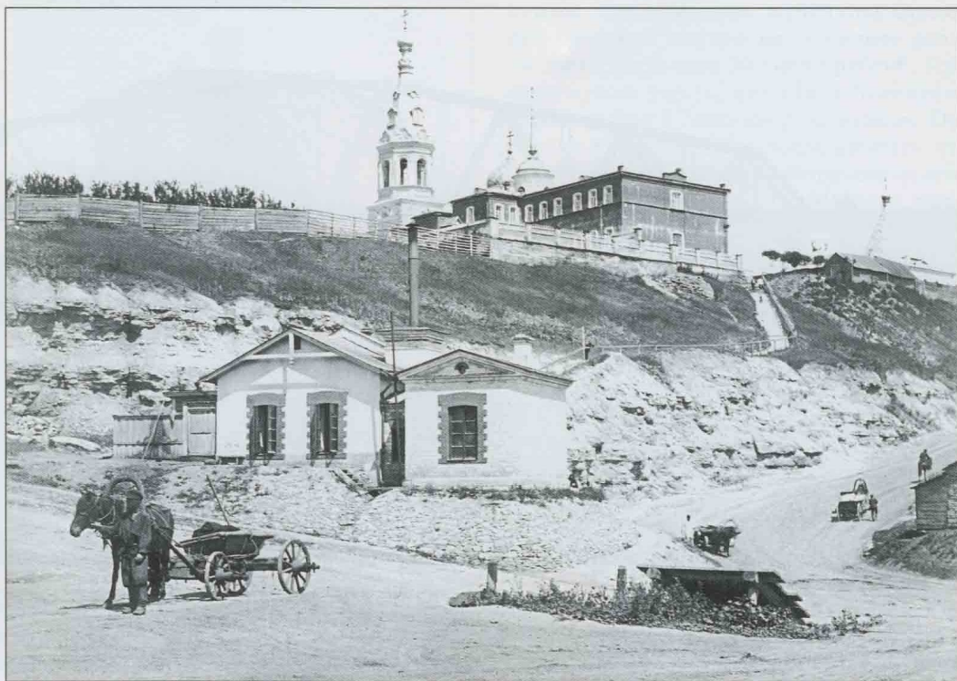
Перестроенное водоподъемное здание на станции Ливны. Фото из фондов ЦНТБ.
