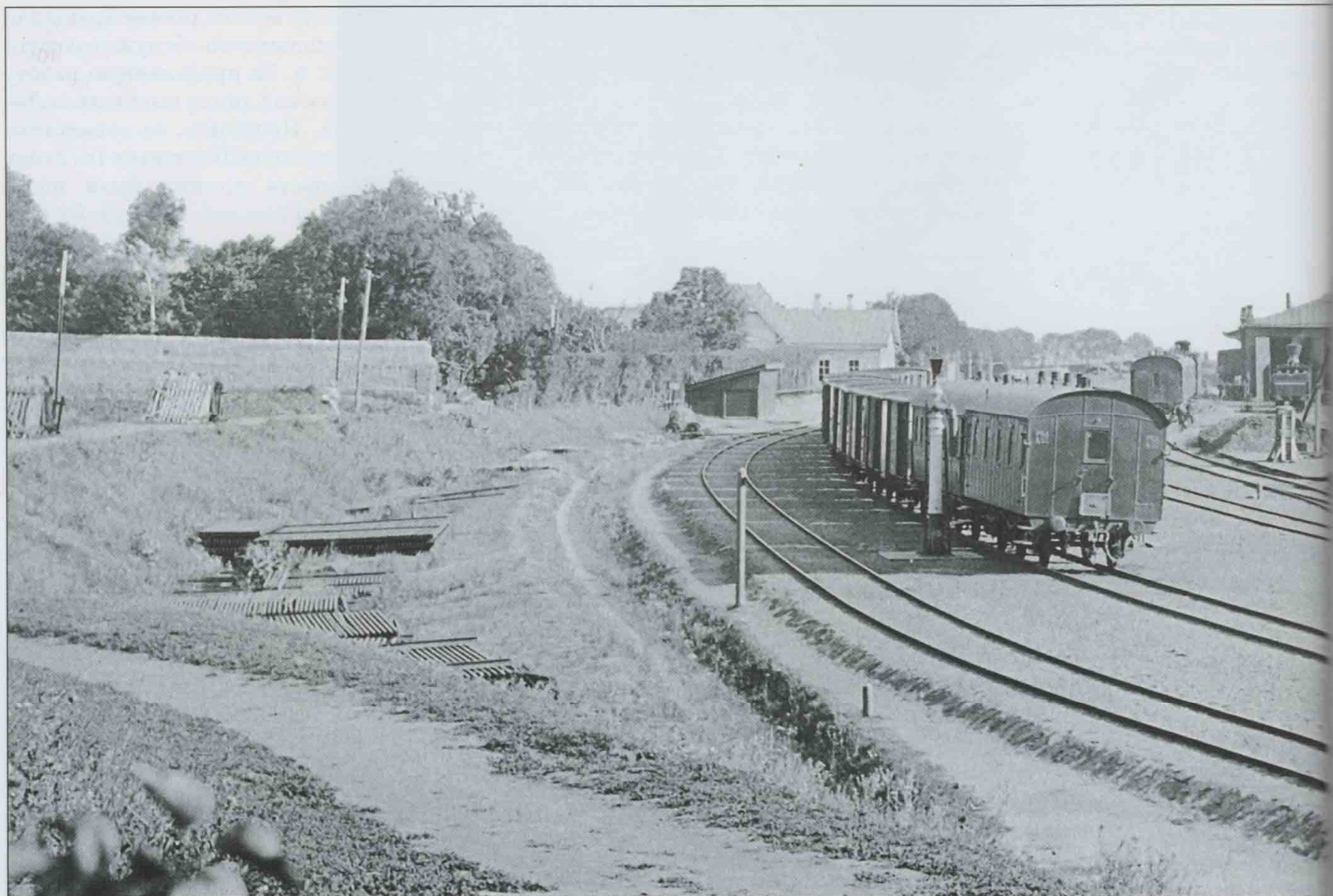
Вид станции Ливны после перешивки на широкую колею. Фото из фондов ЦНТБ.
