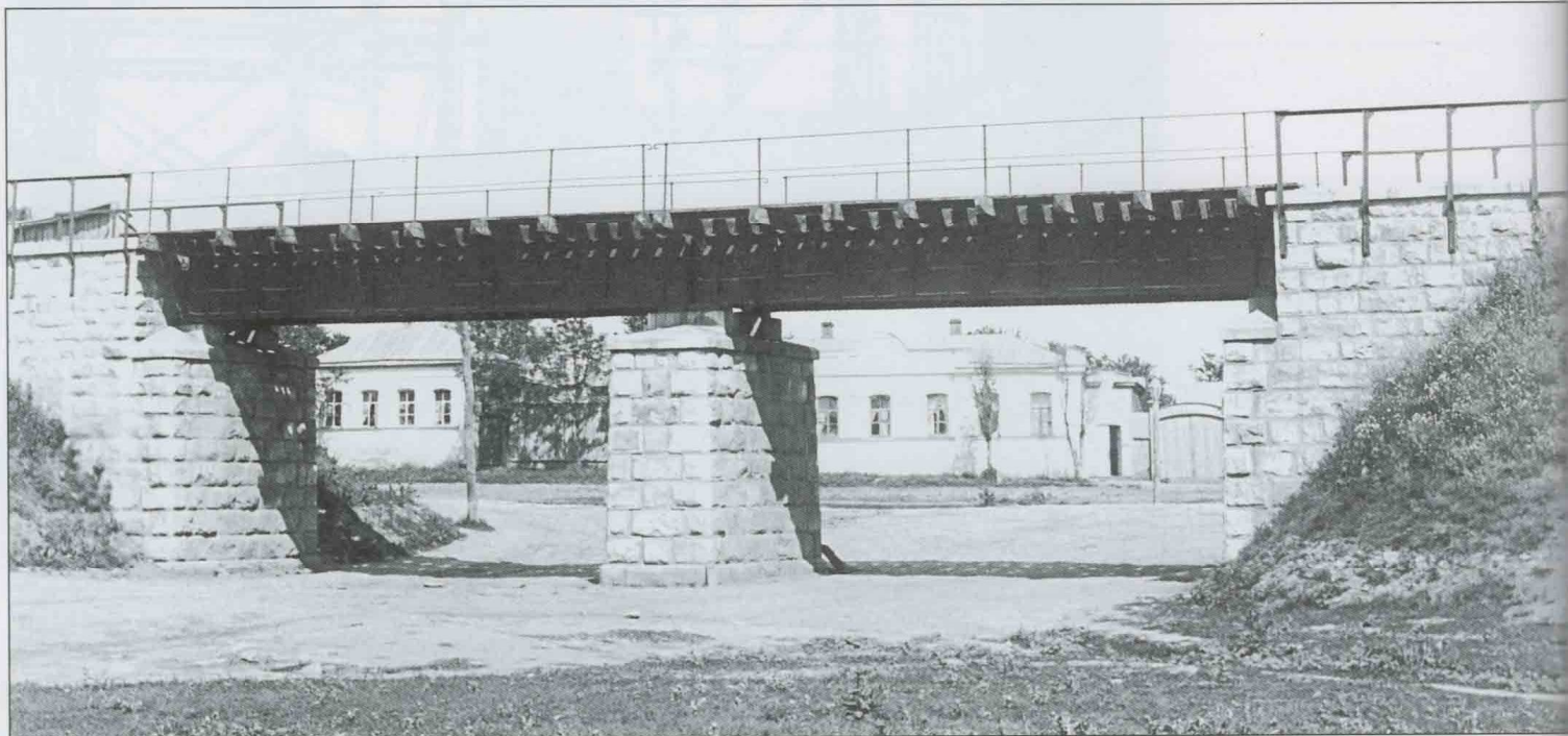
Путепровод на 65-й версте. Фото из фондов ЦНТБ.
