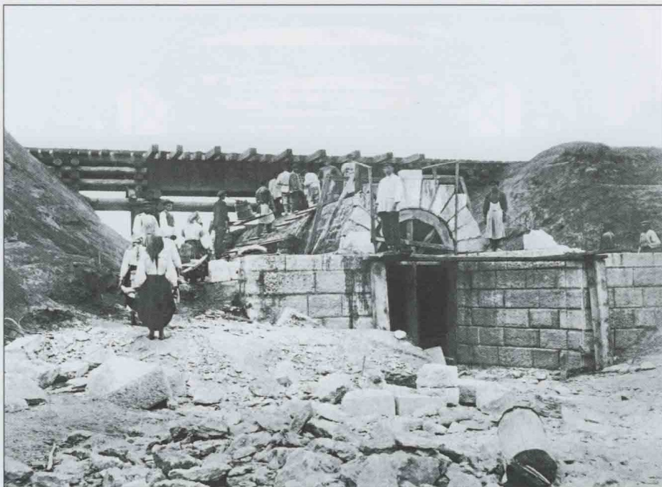
Перестройка трубы отверстием 0,75 сажени на 121-й версте под эстакадой на обходном пути. Фото из фондов ЦНТБ.
