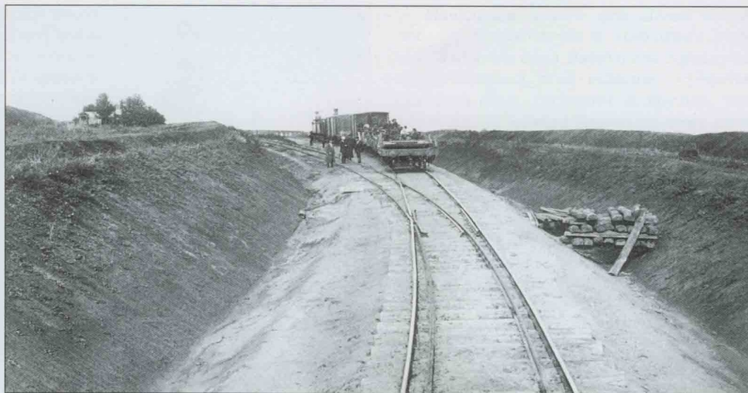
Сплетение путей широкой и узкой колеи во время перешивки. Фото из фондов ЦНТБ.
