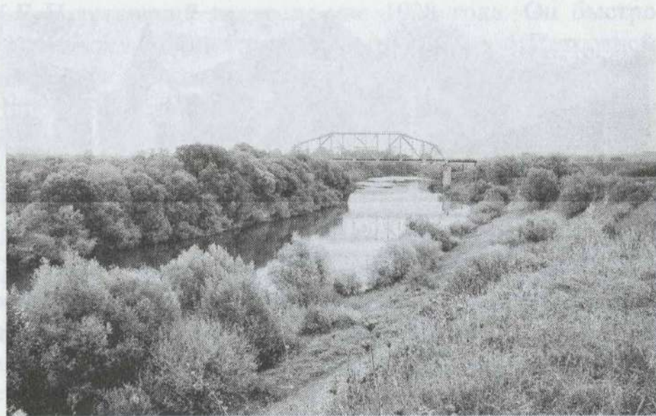
Железнодорожный мост через р. Сосну в Ливнах.
