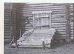
Ганок для подъема пушек в башню Сужского острога.
