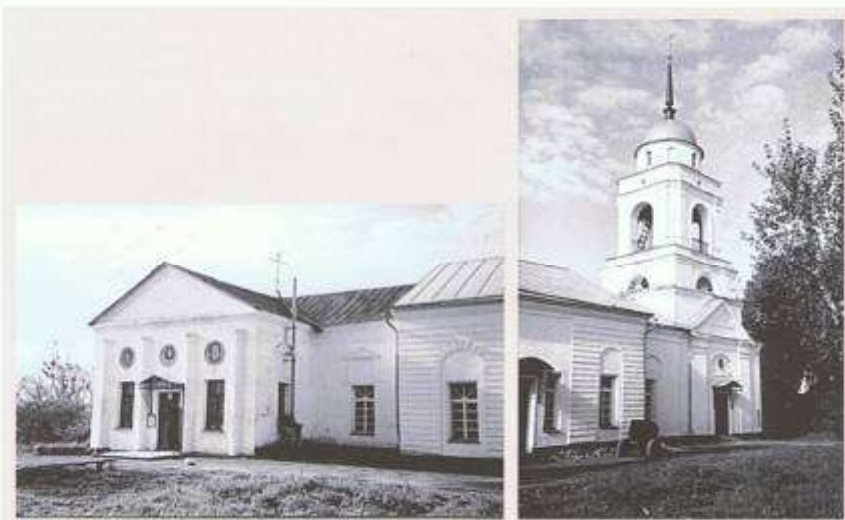
Фрагмент северного фасада.
