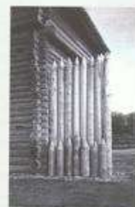
Острожная стена Братского острога.
