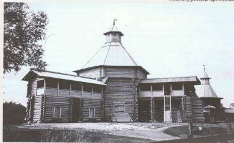
Вид на башню Сужского острога с внутренней стороны.
