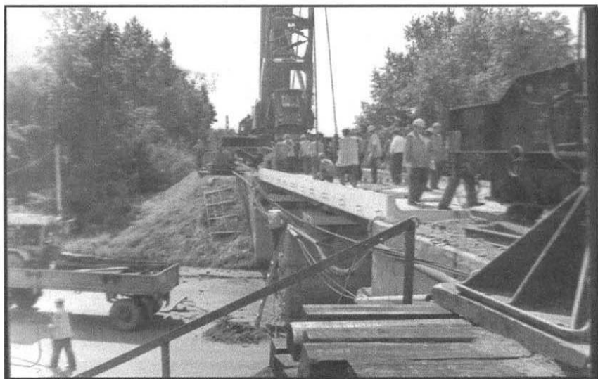
Строительство моста объездной дороги в Стрелецкой слободе
