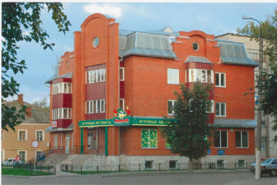
Жилой дом по ул. Горького
