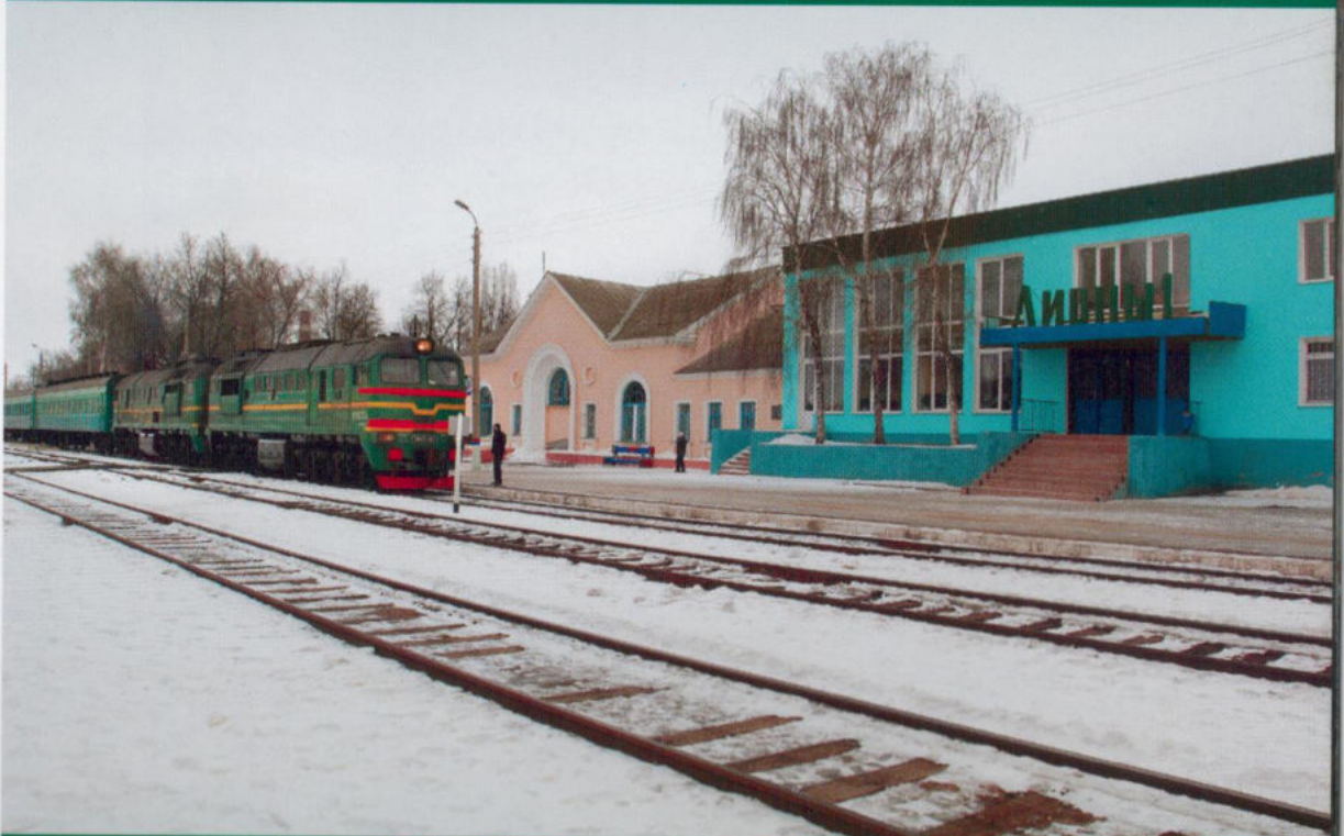
Железнодорожная станция «Ливны-1»
