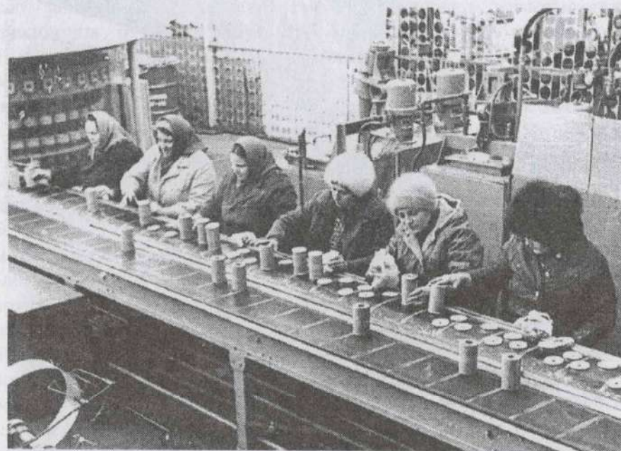
Сборка фильтрующих элементов для «КАМАЗ» на поточной линии в цехе изготовления фильтрующих элементов ЛААЗа. Февраль 1980 г.
