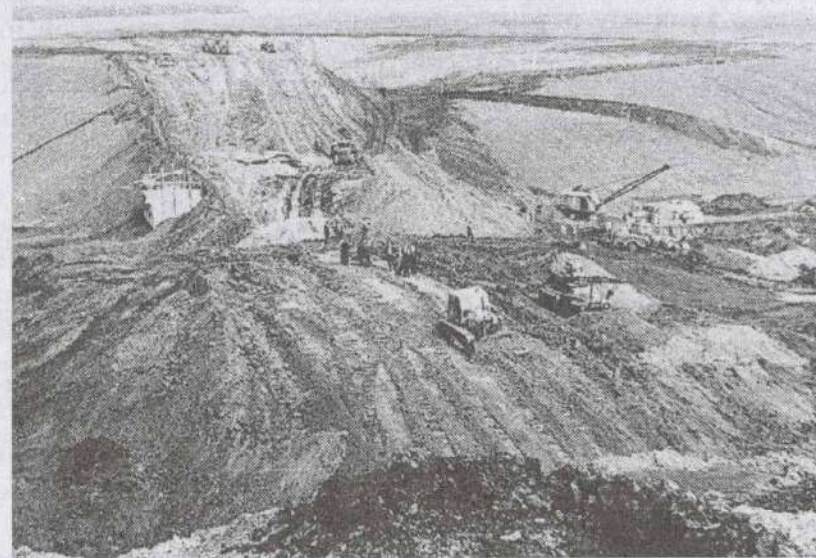
Идет отсыпка плотины «Блынское» озера. Перекрывается Ливенка Лесная. Октябрь 1970 г.
