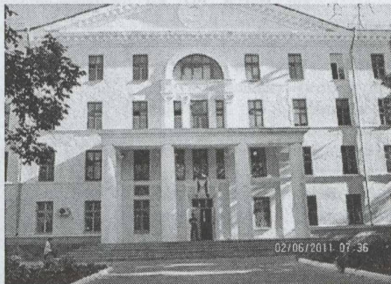
Здание районной больницы
