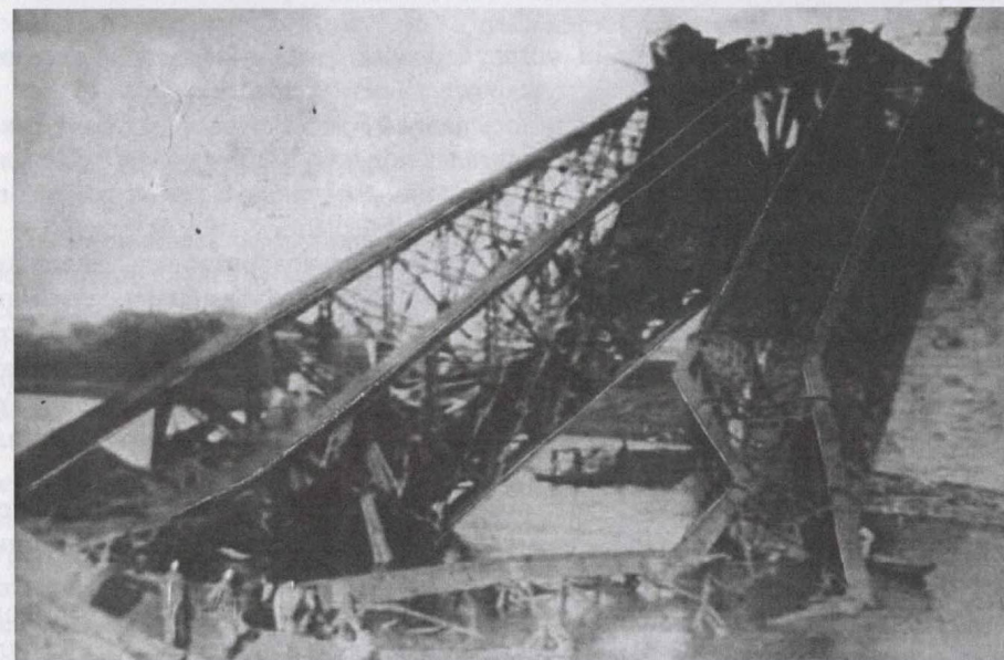
Разрушенный железнодорожный мост через реку Сосну
