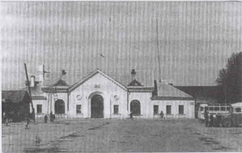
После войны построили новое здание вокзала
