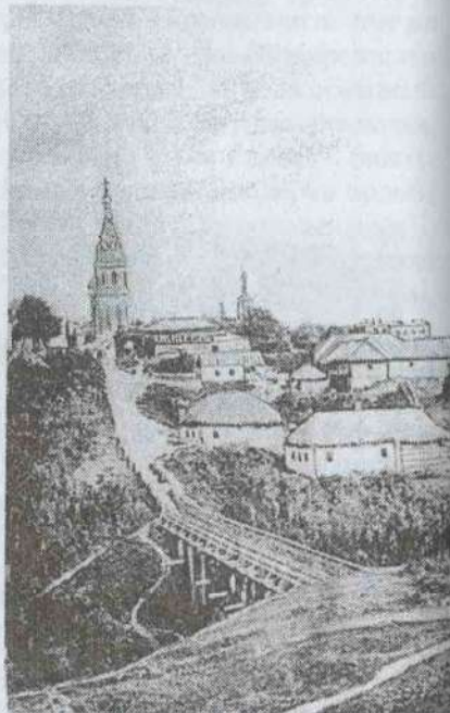
Мост через Пересыханку, начало XX века
