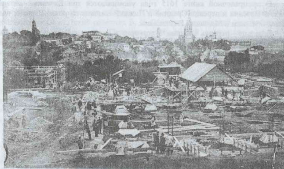
Строительство птицекомбината, 1928 год
