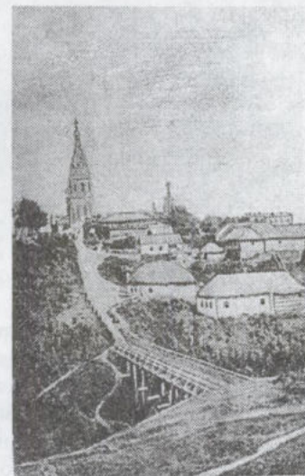
Мост через Пересыханку, начало XX века
