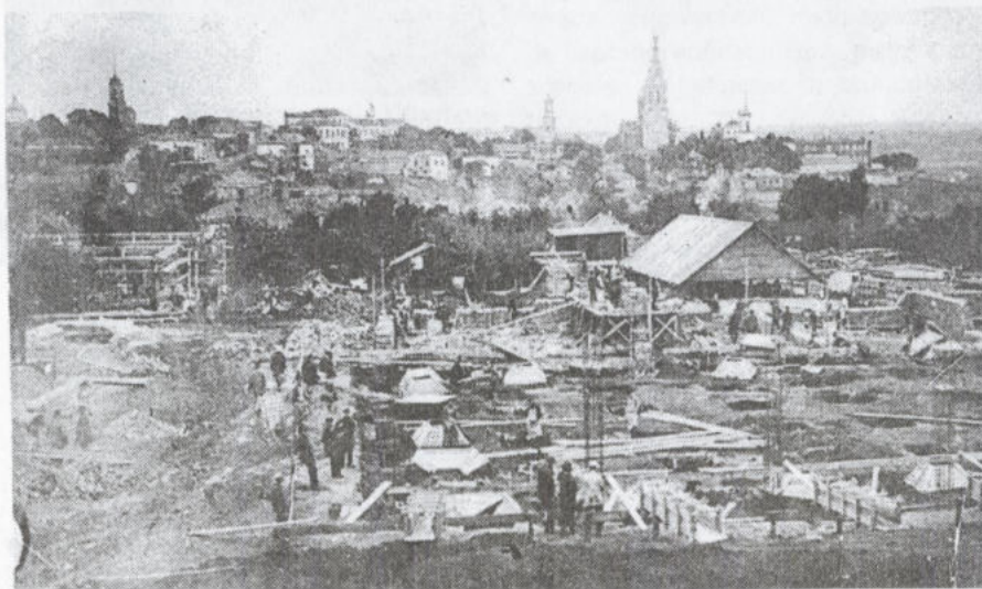
Строительство птицекомбината, 1928 год
