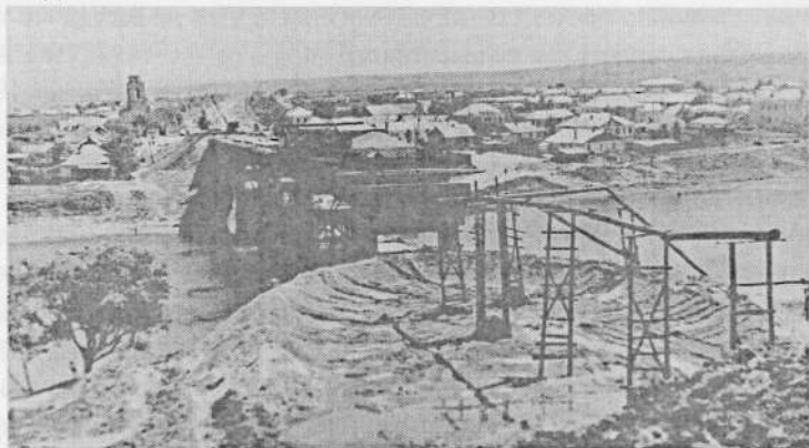
Строительство моста, 1963 г.
