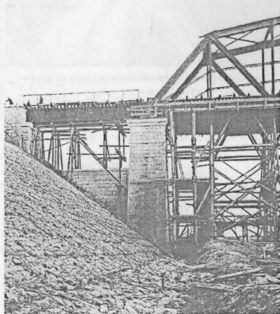
Южная опора моста
