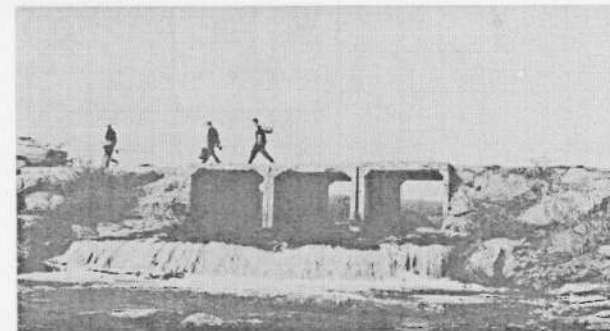
Мост в районе завода ЖБИ
